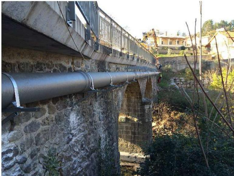
Figure 19 : Photographie d'illustration de la technique d'encorbellement
